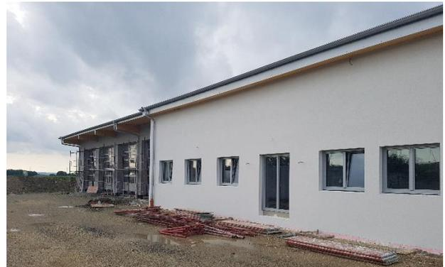
Derzeit wird im Gebäude noch an den Elektroinstallationen gearbeitet. Danach sind die Malerarbeiten fertig zu stellen und die Rasterdecken müssen angebracht werden.
